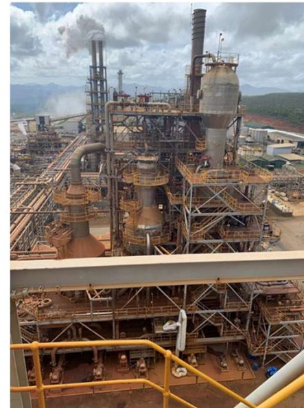
Réacteur HPAL: lixiviation haute pression du minerai à l' H_2SO_4
